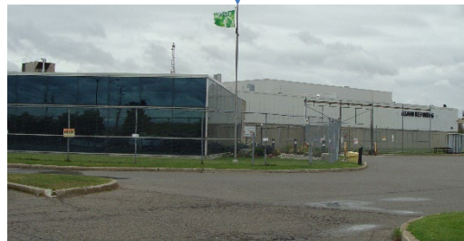
北米精錬事業 (精錬&倉庫設備)
