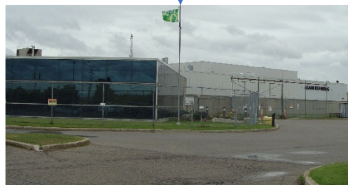
北米精錬事業 (精錬&倉庫設備)
