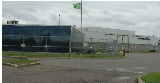
北米精錬事業 (精錬&倉庫設備)
